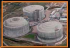
Phase 2 LNG storage tanks
